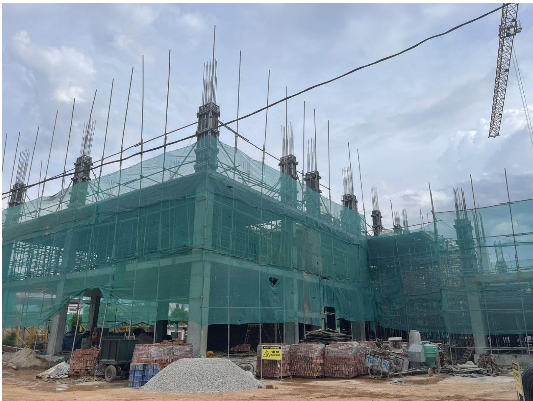
Hình ảnh thi công tại công trình Bệnh viện TNH Lạng Sơn
